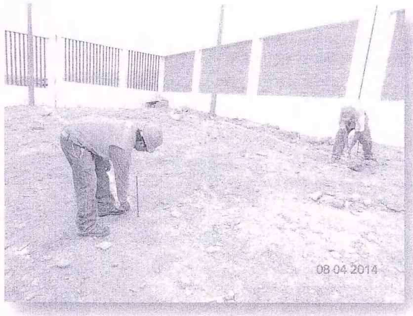
Foto 01. Se muestra el proceso de trazo inicial de Obra (Caseta para Subestación y Caseta de Fuerza)
