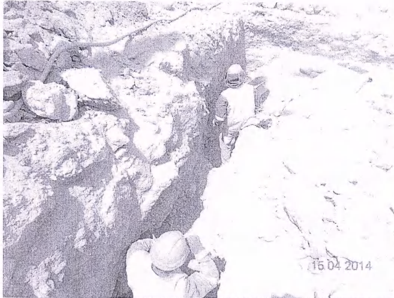
Foto 03. Excavación de zanja para zapatas y Cimentación en terreno Semi calichoso, Rocosos, empleando compresora neumática con 02 Martillos
