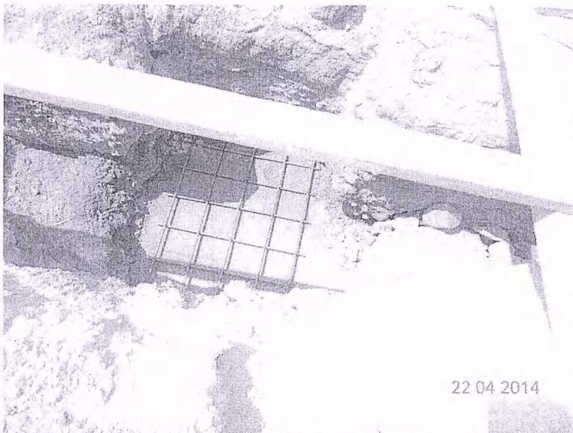
Foto 04. Se aprecia el armado desarrollado para las zapatas (partida Nueva)
